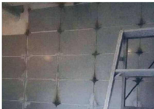
壁面施工 (四隅溶接施工)
